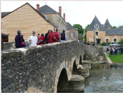
Le vieux pont à Asnières-sur-Vègre
